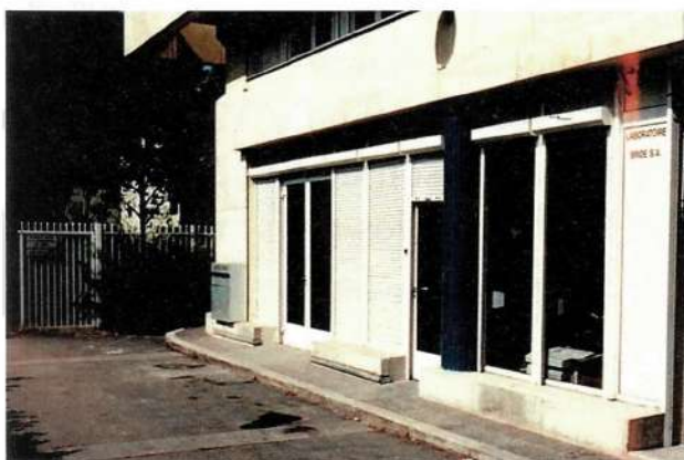
Fig. 11 : façade du laboratoire Bride, 269, avenue de Laon, 1996.
